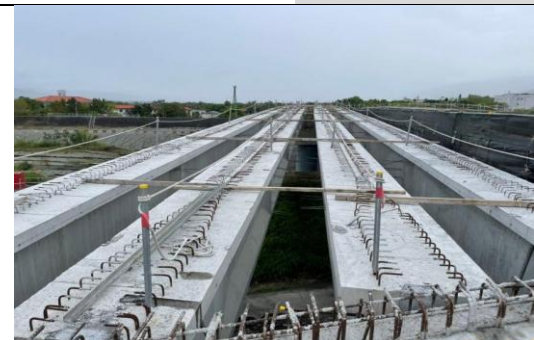
照片 8：吊放後-木料角材橫向連結
