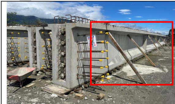
照片 5：吊放前-斜撐可均佈於梁身
